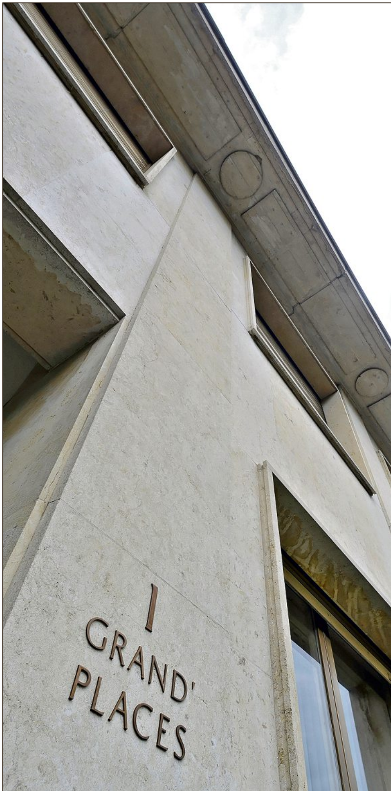
Les locaux de Bocard & Partenaires SA, à Fribourg. VINCENT MURITH
